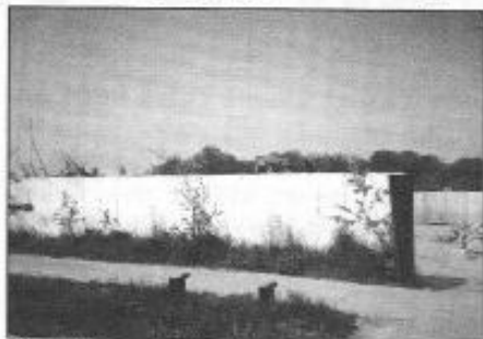
Śmietnik na Batowicach oddzielono od cmentarza murem z płyty.
